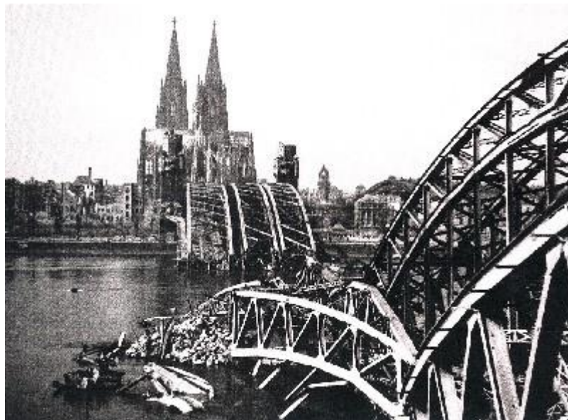
Fig. 4: Puente de Hohenzollern, en Colonia (Alemania), destruido en 1945 como consecuencia de los bombardeos durante la Segunda Guerra Mundial.
