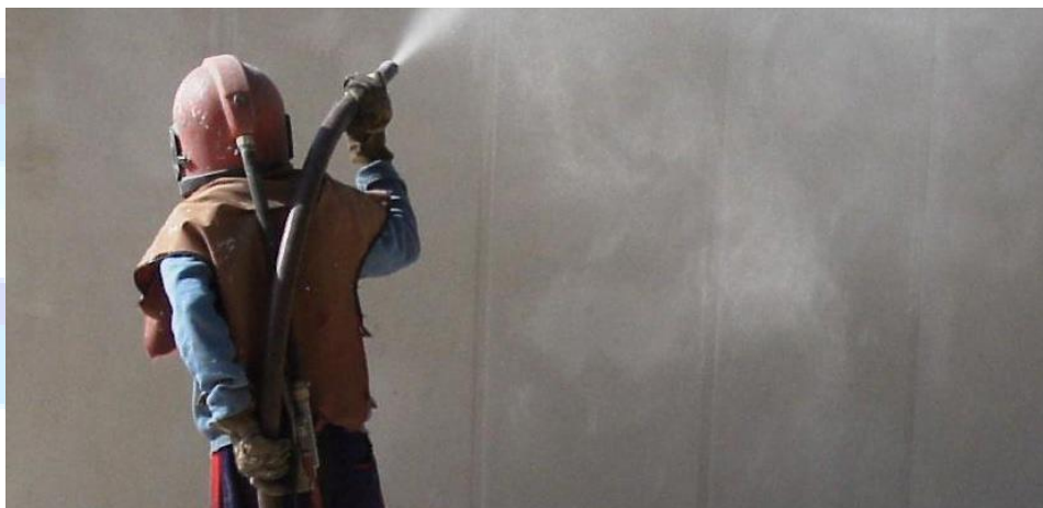
Fig. 6: Operaciones de chorreado de arena sobre un elemento de acero.
