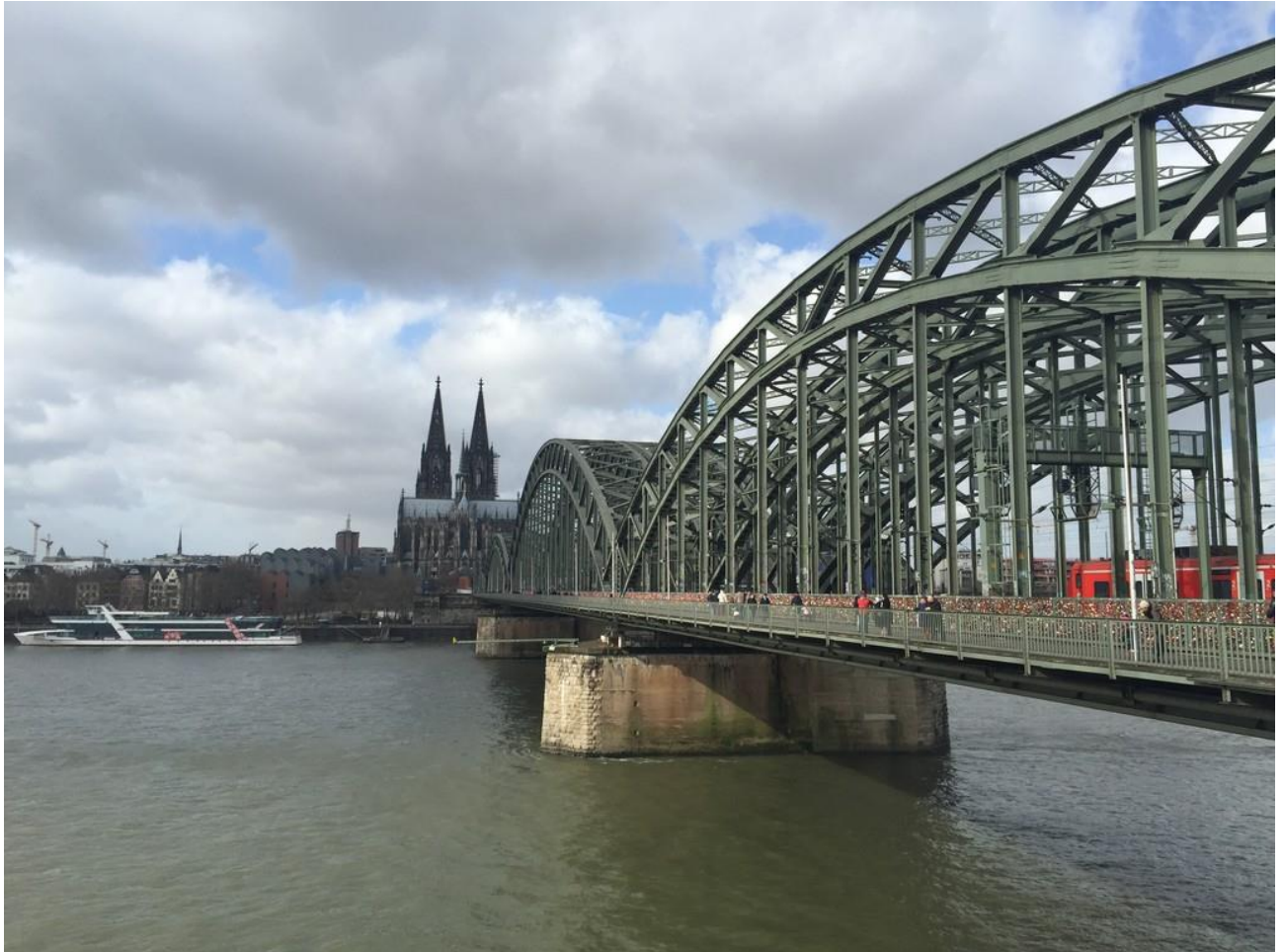
Fig. 1: Puente de Hohenzollern, en Colonia (Alemania). La aplicación del acero a la ingeniería estructural en el siglo XIX abrió nuevos horizontes en el panorama ingenieril.
