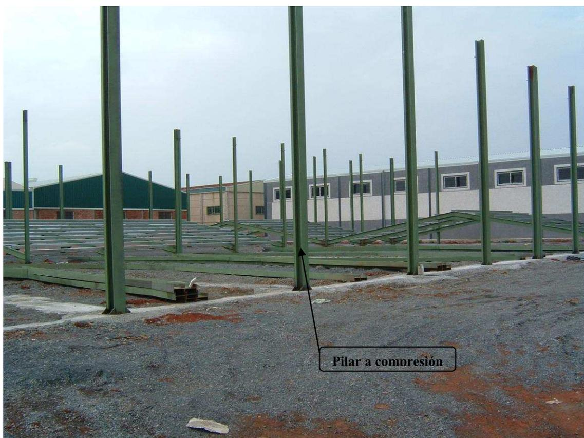
Figura 1.4: Elementos estructurales que trabajaran a compresión por excelencia.
