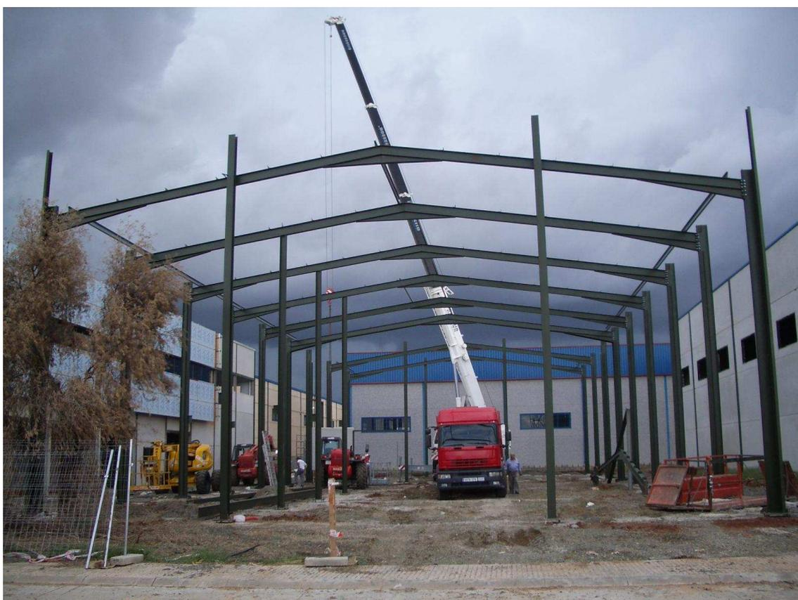
Figura 3.2: Vista frontal de un pórtico tipo.
