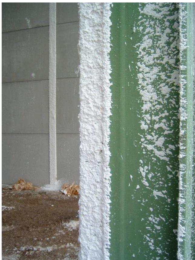
Figura 2.2: Pilar recubierto protección contra fuego.
