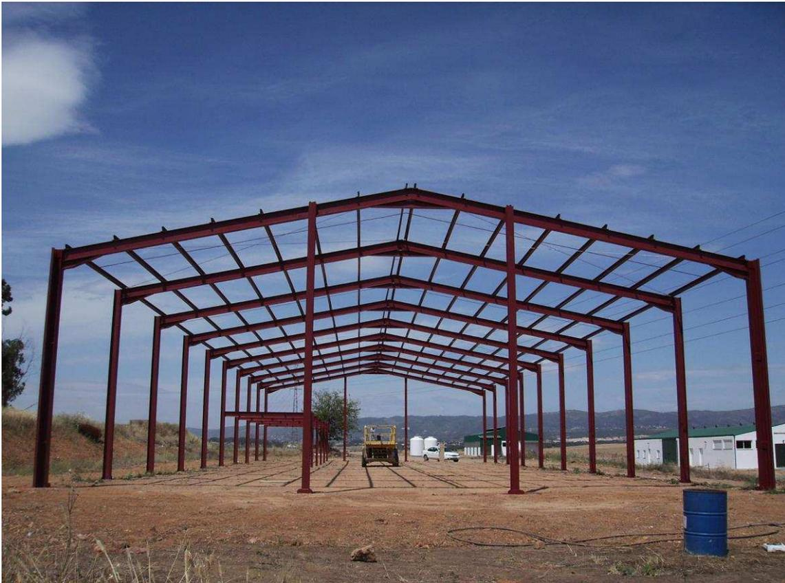
Figura 1.3: Estructura metálica salvando una gran luz.
