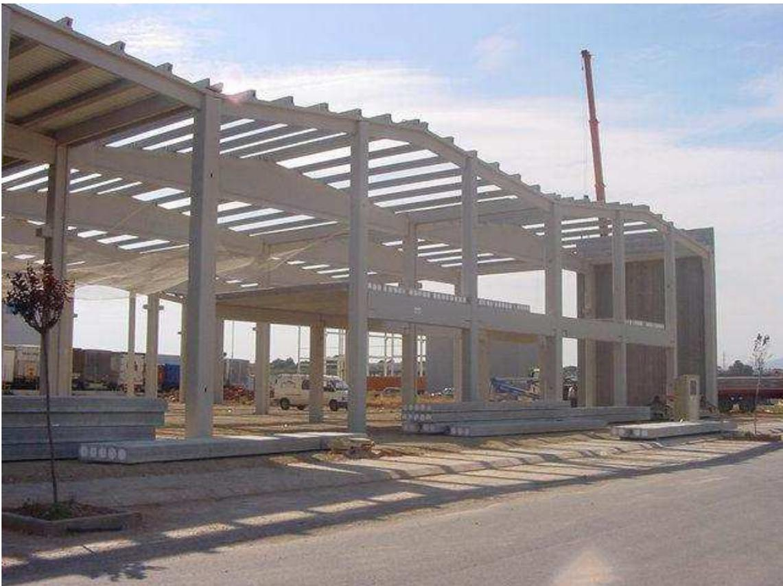
Figura 1.2: Estructura de nave almacén hecho con prefabricados de hormigón.
