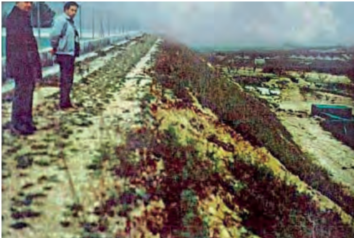
▲ Figura 7.4.17.1. Zona de afección del deslizamiento superficial
