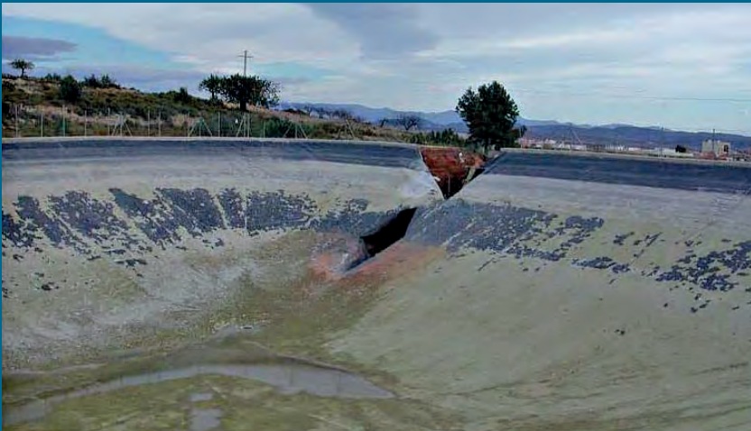
▲ Figura 7.4.5.6. Vista de la rotura de la fotografía anterior, desde el talud interior
