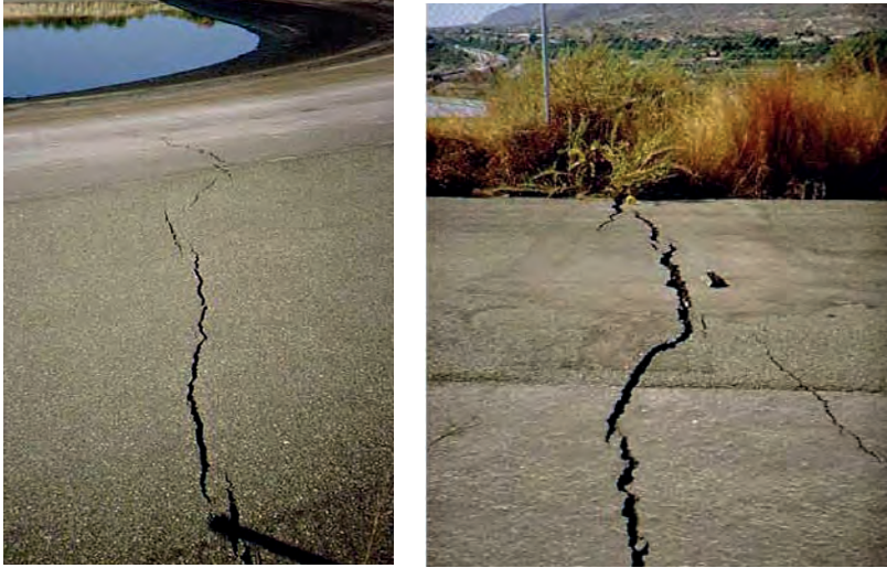
▲ Figura 7.4.7.2. Detalle de las grietas transversales en coronación
