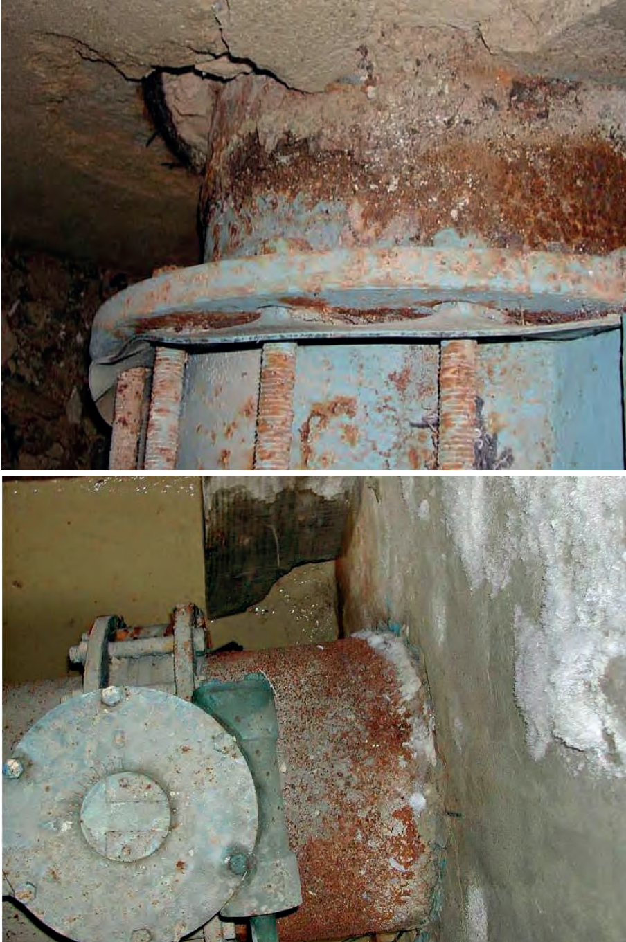
▲ Figura 7.4.15.3 Fuerte oxidación en conducciones de salida de acero con edades del orden de 15 años
