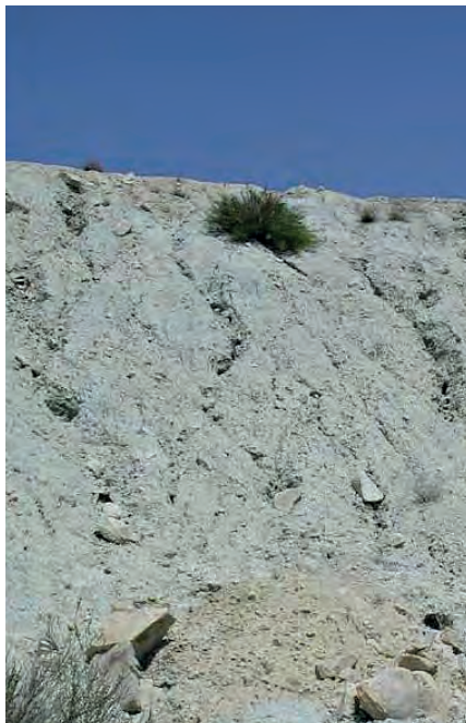
▲ Figura 7.4.23.1. Formación de cárcavas en talud exterior
