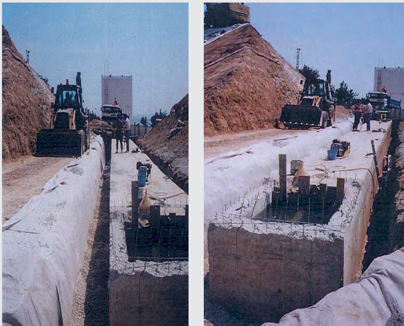
▲ Figura 7.4.2.8. Detalle de la reparación con la envoltura de gravillado la galería en presión de salida/entrada y la arqueta de toma.
