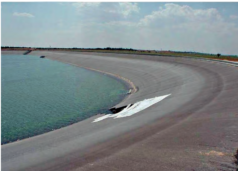
▲ Figura 7.4.8.1. Vista por el talud interior
