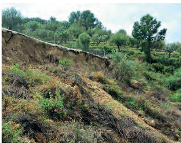
◀ Figura 7.4.18.1. Deslizamiento superficial de la capa externa del terraplén tras lluvias intensas
