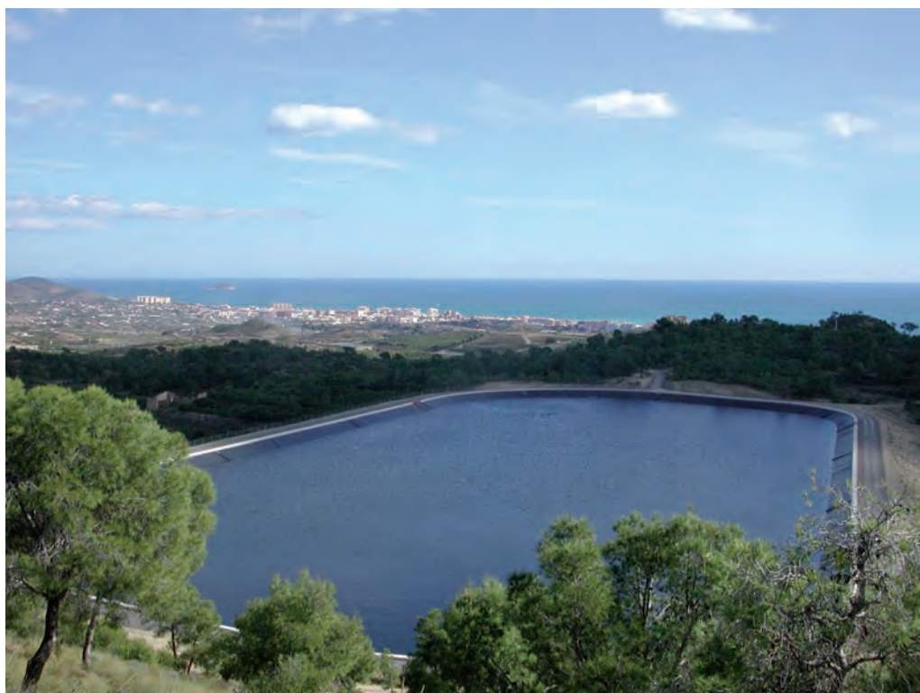
Vista general de la balsa Alfondons, en el término municipal de La Vila Joiosa (Alicante). Capacidad de la balsa 300.000 m 3 .
