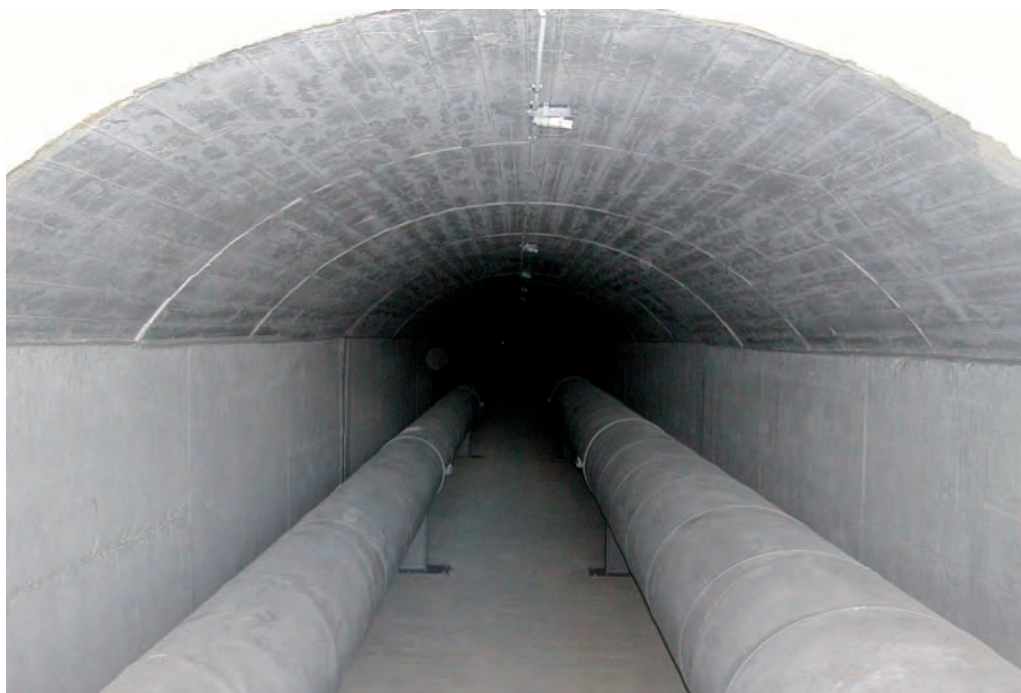
Galería visitable de la balsa de Alfondons, que aloja las conducciones de entrada y salida de 600 mm y 800 mm de diámetro, respectivamente.
