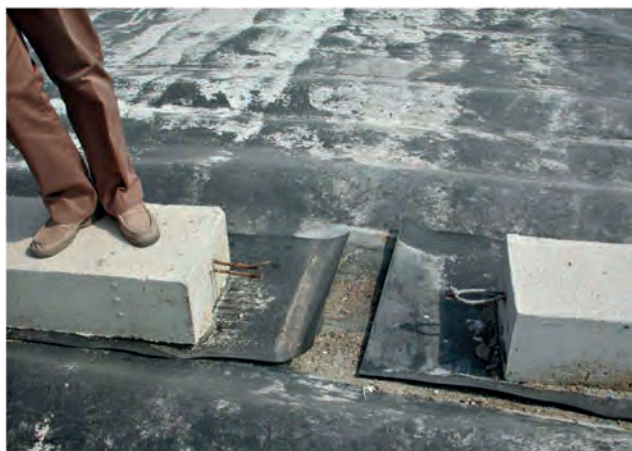
Figuras 7.4.22.3.▶ Deslizamiento de lastres de hormigón articulados por oxidación del cable de unión
