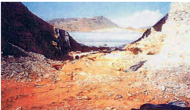
◀ Figura 7.4.4-3 Vista de la brecha
