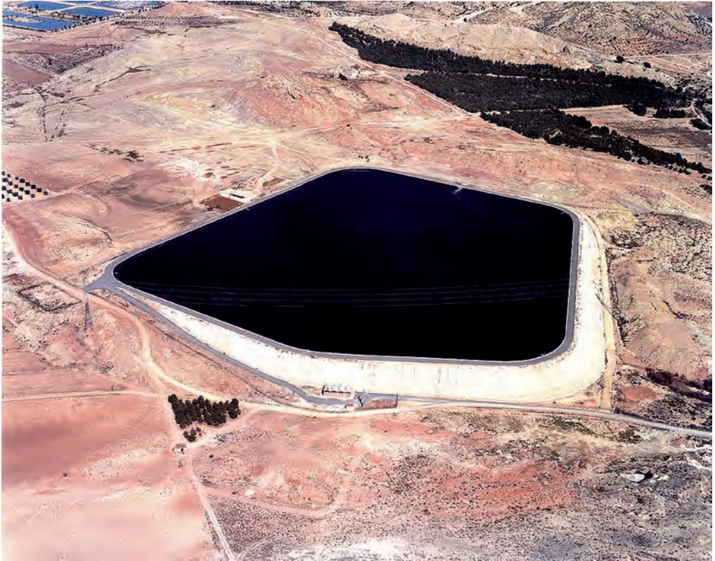
Vista general de la balsa Los Cabezos, en el término municipal de Villena (Alicante). Capacidad de la balsa 640.000 m 3 . Construida sobre terrenos con muy alto contenido de yesos
