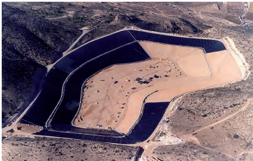
Balsa Cerro de las Águilas, en el término municipal de Monforte del Cid (Alicante) durante su ejecución. Capacidad de la balsa 1.100.000 m 3 .
