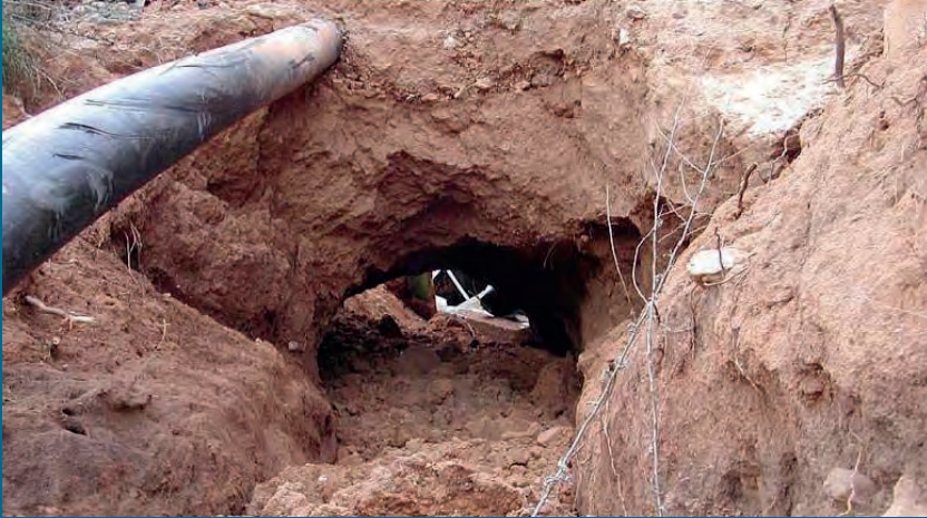
▲ Figura 7.4.5.5. Vista desde el talud exterior. Tubificación en la zona del desagüe de fondo, con tubería de PEAD. Obsérvese en la parte izquierda, la nada recomendable práctica de emplazar la conducción de llenado por el terraplén y, en este caso, por la zona del desagüe de fondo
