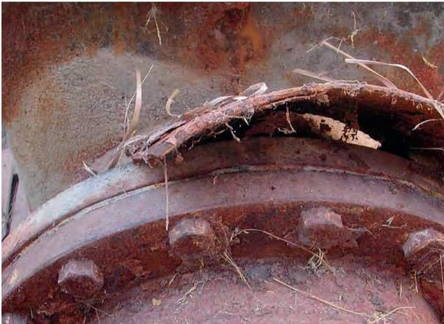
▲ Figura 7.4.15.1. Casquete de tubería de 4 mm. de espesor, extraído de la rotura por oxidación de la conducción de salida
