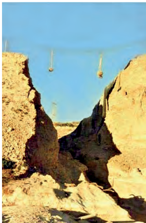
▲ Figura 7.4.3.1. Rotura del desagüe de fondo
