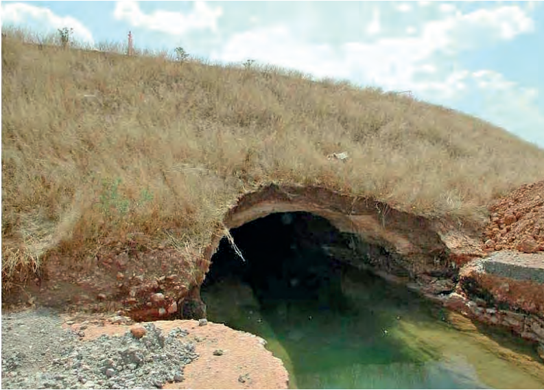
▲ Figura 7.4.8.2. Vista por el talud exterior
