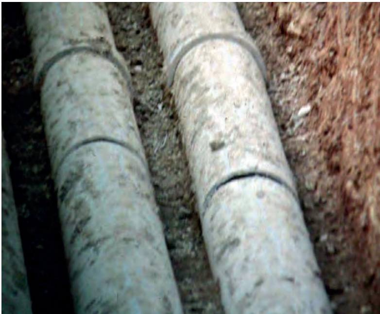
▲ Figura 7.4.16.1. Vista de la rotura por flexión en las conducciones de salida de fibrocemento
